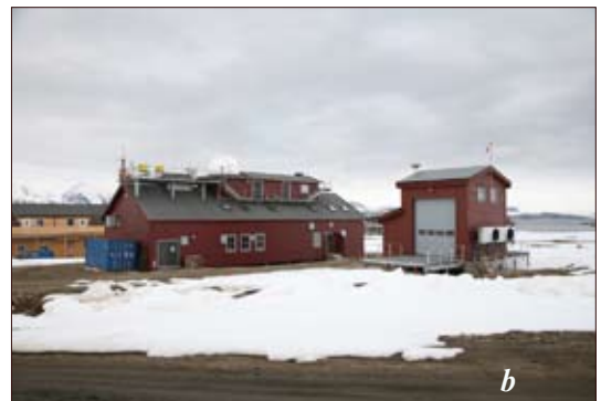
Abb. 5.1-11: a) Internationale Forschungssiedlung Ny-Ålesund; Norwegen, Deutschland, Frankreich, Italien, Großbritannien, Schweden, Japan China und Süd-Korea betreiben hier insgesamt 13 verschiedene Forschungsstationen (Foto: Biola Haschek, Graz); b) Gebäude des Atmosphären-Observatoriums an der deutsch-französischen Station AWIPEV (Foto: Biola Haschek, Graz).
